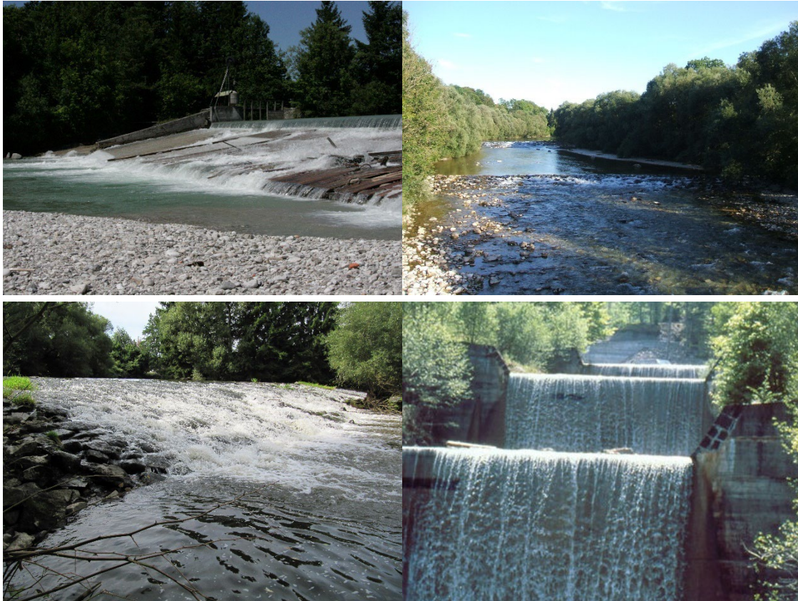
Abbildung 50: Verschiedene mögliche Querbauwerke (Quelle: (Kleinwasserkraft Österreich, 2021b))
